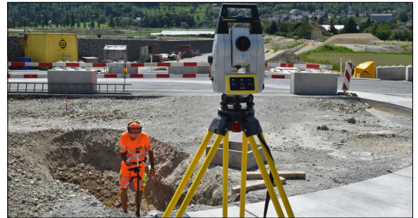
Maschinengesteuerter Belagseinbau Eigene Darstellung
