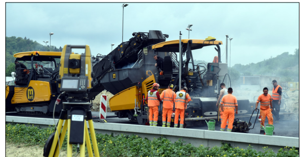
Maschinengesteuerter Belagseinbau Eigene Darstellung
