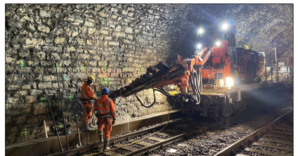
Tamrock-Bohrwagen auf Arbeitszug beim Ankereinbau Eigene Darstellung
