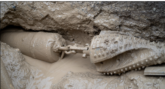
Rohreinzug Wasserleitung Fährnlibrunnenstrasse Projektunterlagen: Basler & Hofmann AG
