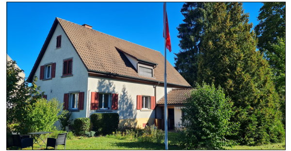
Analysiertes Bestandsgebäude, Baujahr 1925 Eigene Darstellung
