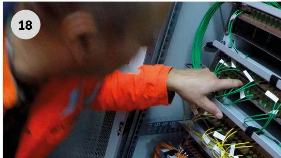
Szenario 1: Reparatur im Technischen Raum 1
