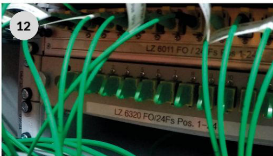
Ausgang LZ 6011, Info für Technischen Raum 2 im UG
