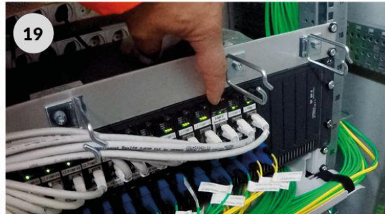
Szenario 2: Reparatur im Technischen Raum 2
