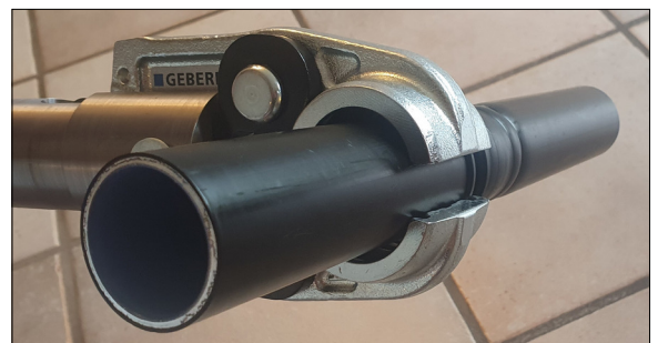
Pressvorgang Rohrverbindung Eigene Darstellung
