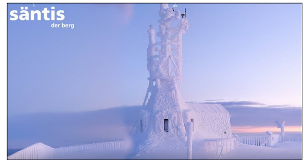
Vereisung der Wetterstation auf dem Säntis MeteoSchweiz
