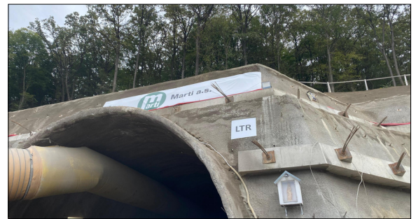
Tunnelportal linke Röhre Eigene Darstellung
