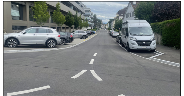
Fertig sanierte Kreuzung Fähnlibrunnenstrasse-Kohlrainstrasse Eigene Darstellung
